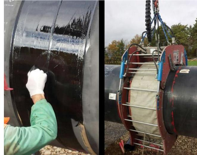
**ETI** è specializzata per i lavori di fasciatura e verniciatura a protezione dei giunti saldati attraverso l'applicazione di fasce termorestringenti. Le fasce vengono applicate sui giunti saldati compresi tra elementi rivestiti in polietilene.
