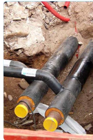
**ETI** esegue il montaggio delle tubazioni. In un sistema di teleriscaldamento il calore viene distribuito agli edifici tramite una rete di tubazioni in cui fluisce l'acqua calda o il vapore.
